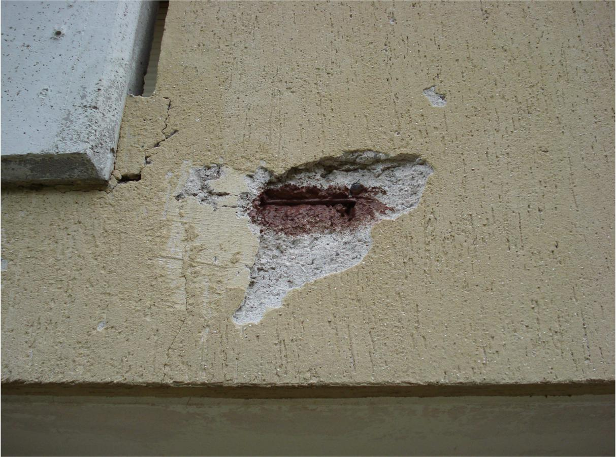
La fase successiva prevedeva l'applicazione dell'isolamento termico tipo a cappotto sulle due pareti poste a nord e sud, che oltre a subire il gravare delle condizioni climatiche estreme, presentavano difetti strutturali molto importanti, quali crepe e fessurazioni molto vistose.
