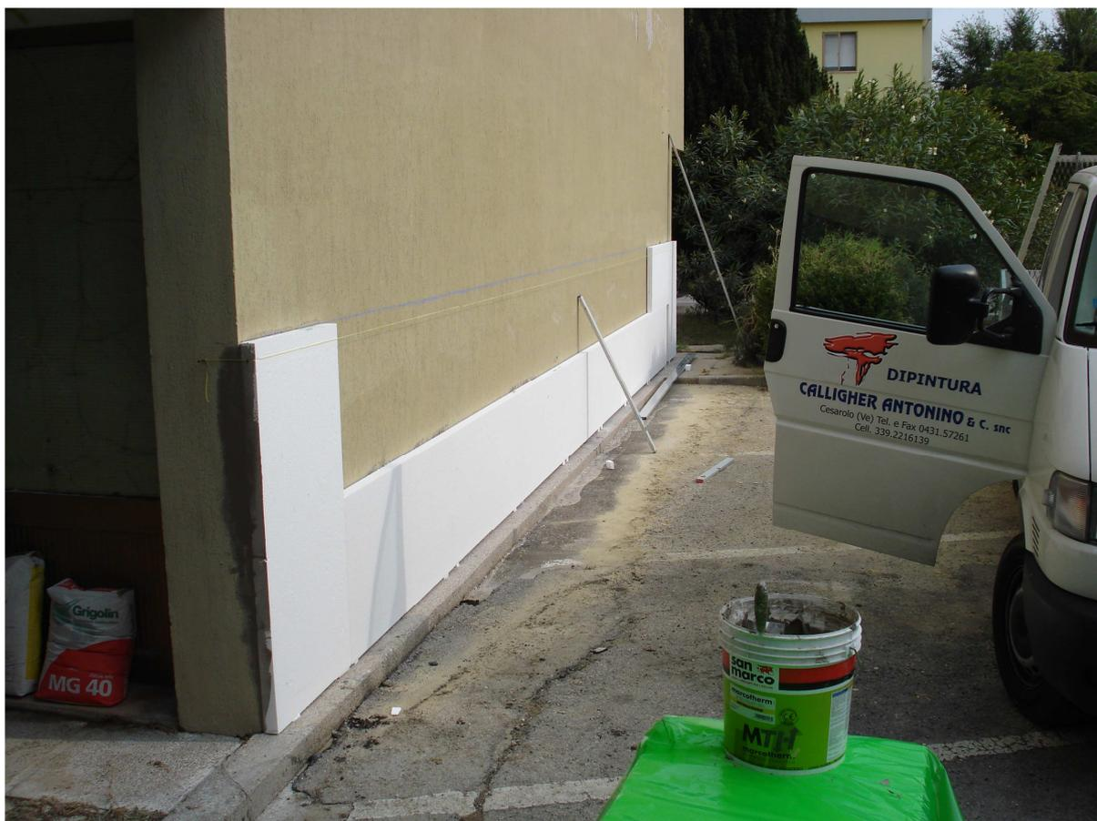
Come si può notare nella sequenza di queste due foto, il montaggio dell'impalcatura è avvenuta dopo l'incollaggio delle prime file guida del
