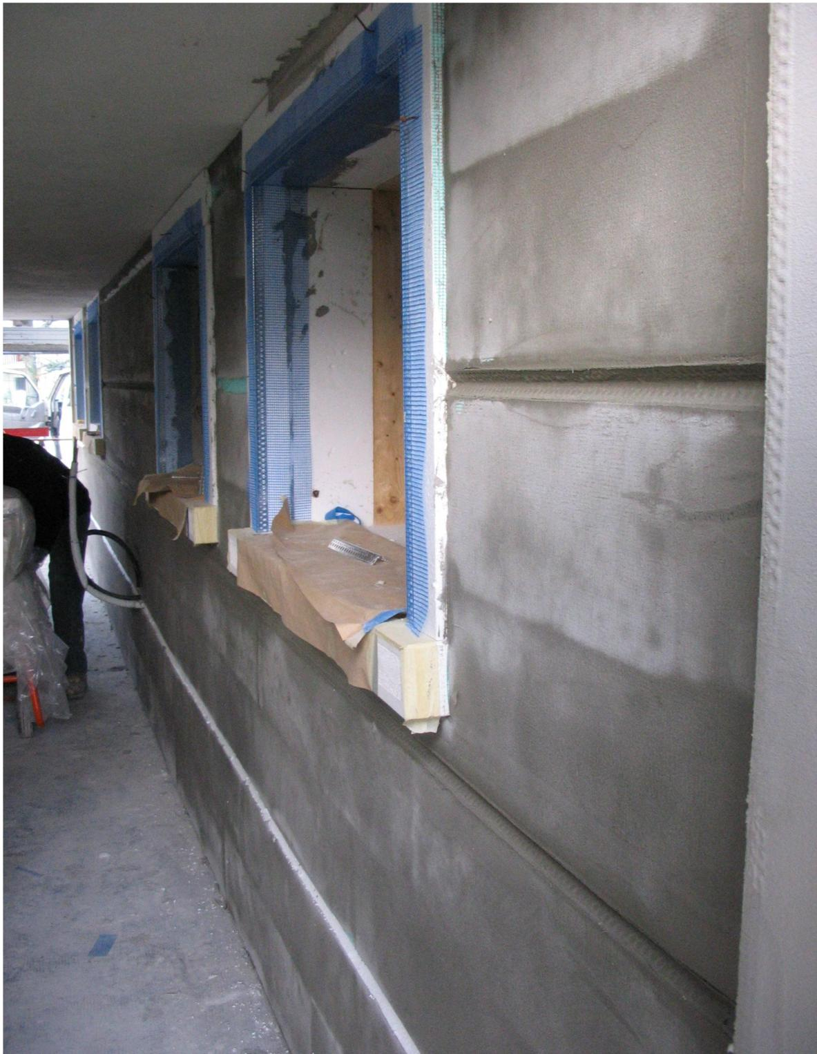
La finitura delle riquadrature è stata eseguita tipo malta fina con il frattazzo di spugna, come tutta la parte inferiore del fabbricato interessata dai bordi fresati, su cui è stato inserito un angolare in alluminio per dare più corpo al supporto.
