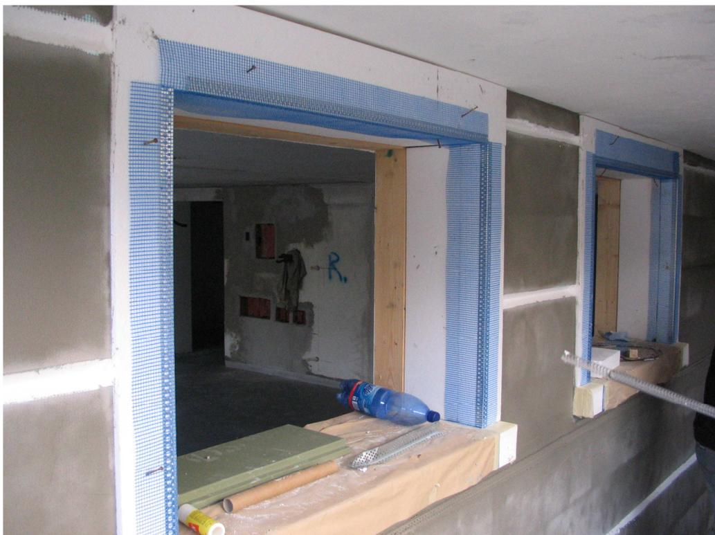
Notiamo nella prossima immagine il particolare delle bordature dei riquadri che sono state eseguite su porte e finestre. Sono stati dapprima incollati pezzi di polistirolo più spessi rispetto a quelli delle pareti, successivamente bloccati con paraspigoli e la rete.
