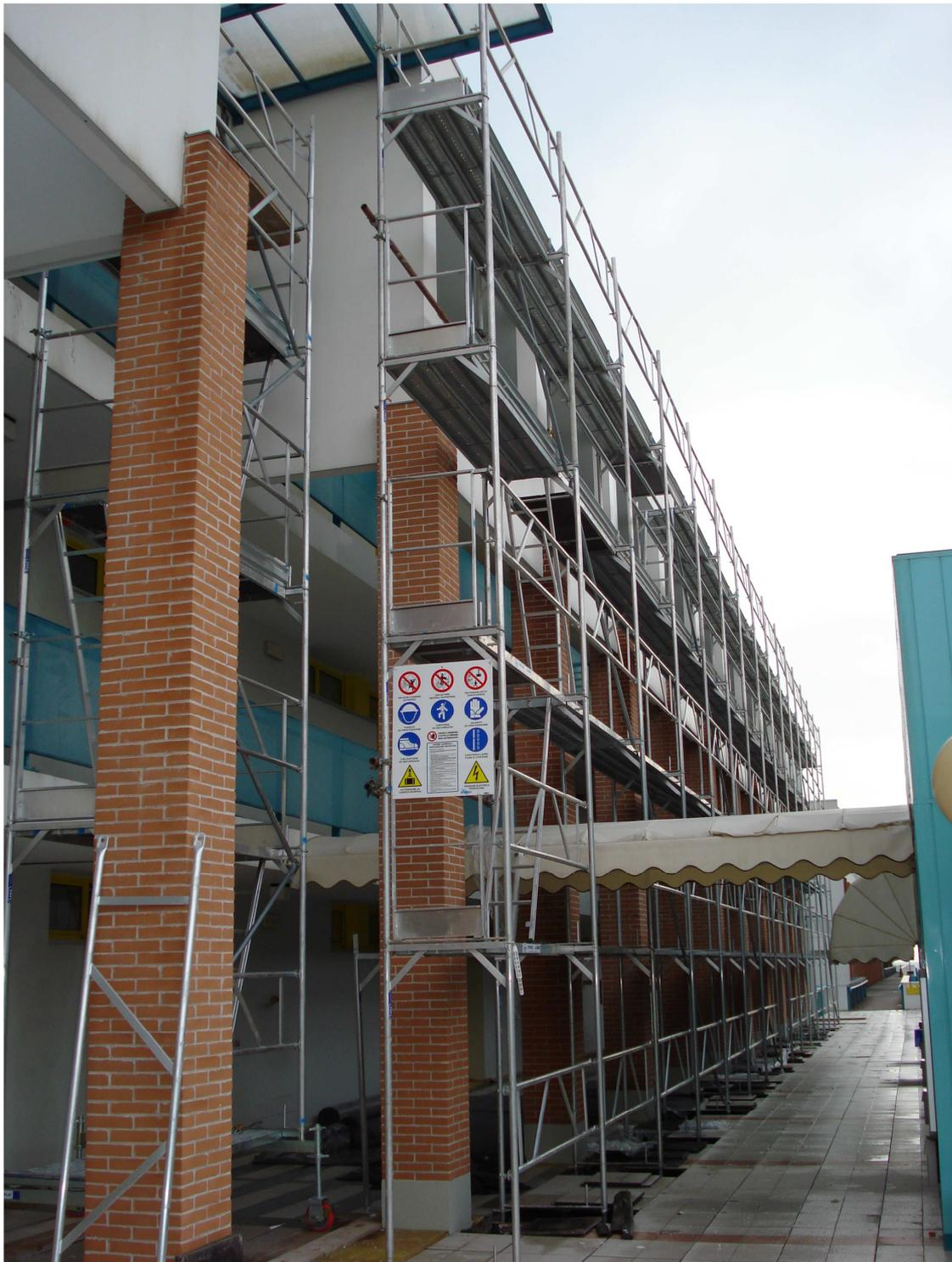
Essendo due fabbricati dalle grandi dimensioni (80,00ml di lunghezza per 12,00 di larghezza con uno sviluppo di 14,00m di altezza ognuno) e costruiti su pilastri e solai in cemento armato con tamponamenti in muratura, sono chiaramente sottoposti a movimenti strutturali decisamente più marcati rispetto ad una piccola costruzione; di
