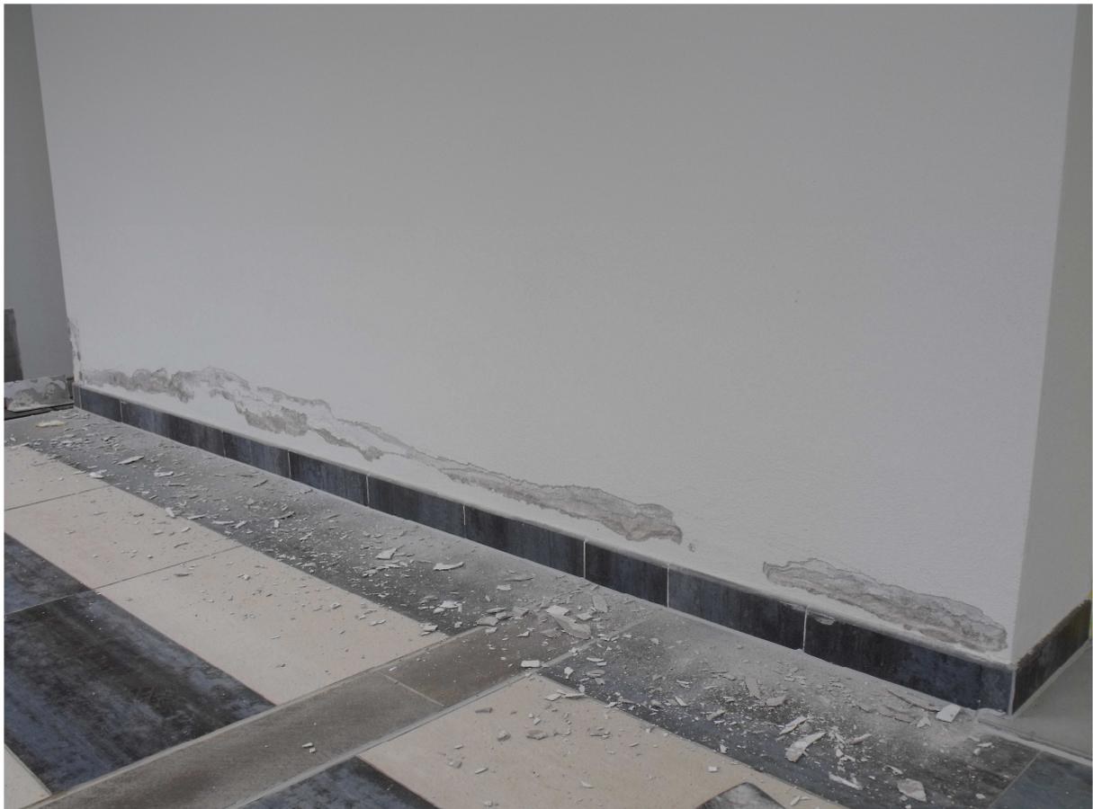
Sotto la supervisione del tecnico, nonché produttore del materiale utilizzato, una malta speciale per risanamenti della linea "COPROX", abbiamo testato il grado di umidità in diversi punti della parete e anche in profondità nell'intonaco, scapellandone una porzione scoprendo il mattone.
