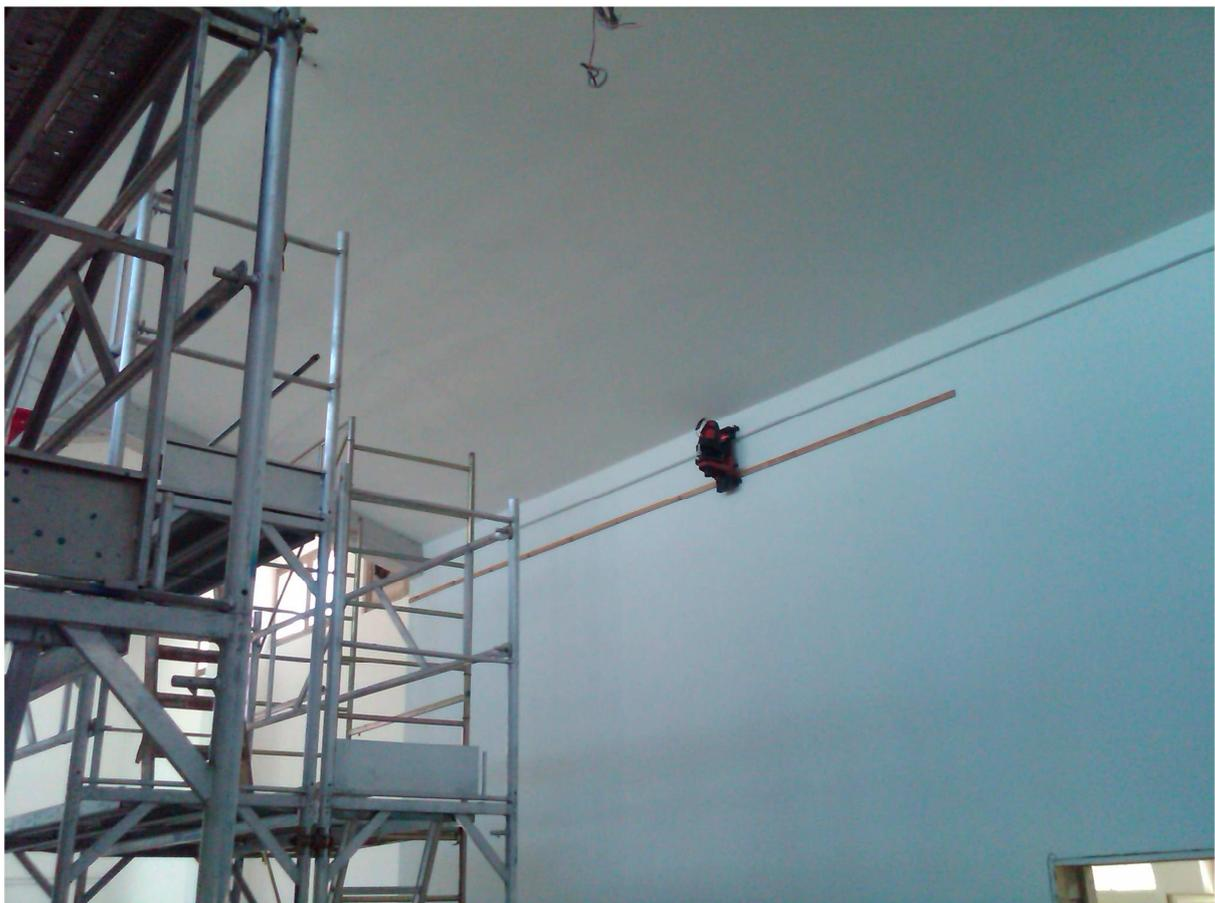
Il passo successivo vedeva l'applicazione dei travetti portanti, fissati al soffitto mediante ancorette.
